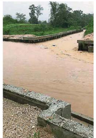
由州府在去年拨款20万所加高的河堤，在最近的连日大雨中发挥了防洪功效，免除居民遭受黄泥水围困之苦。
