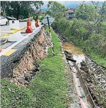
逾百呎的草地連同排水溝和告示牌在斷裂後陷入溪道，導致居民担忧影响排水而发起水灾，冲走更多黄泥而情况恶化。
